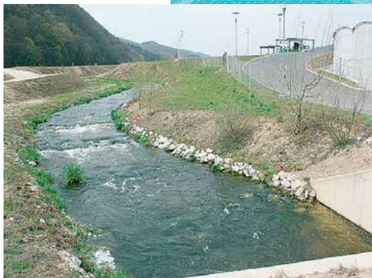
Ribje steze pri hidroelektrarni Blanca na reki Savi
